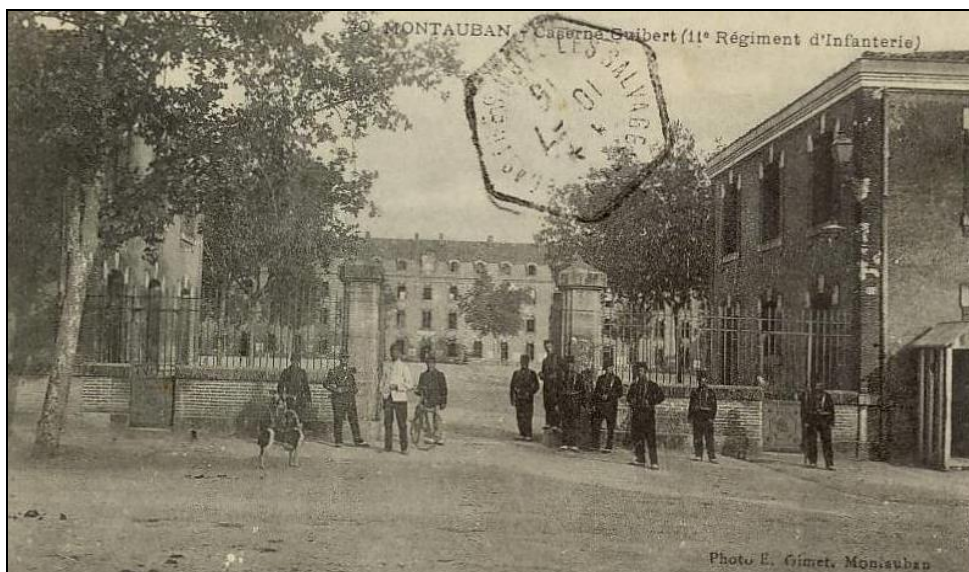
Montauban, la caserne Guibert.
